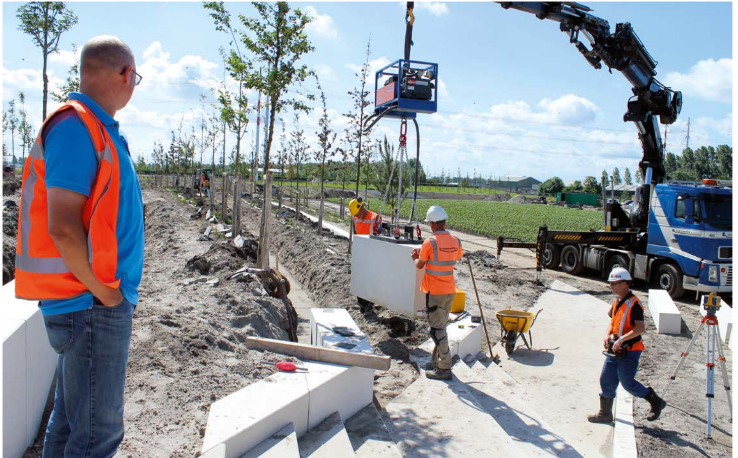
De betonnen blokken variëren in gewicht van 1.860 tot 2.600 kg. Met een hijskraan en zuignap worden ze op hun plek gehesen.
