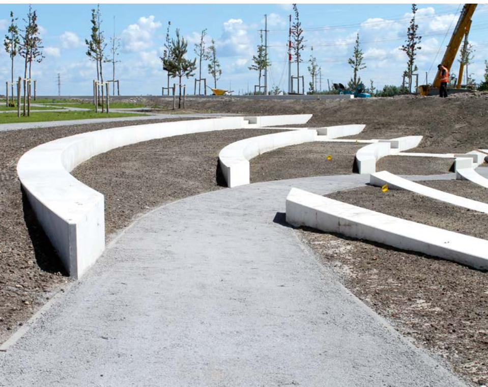
Een halfverhardingspad van 1,5 m breed doorsnijdt de zitmuren van het amfitheater. Alle halfverhardingspaden zijn afgezet met betonnen opsluitbanden (5km in totaal), handig in het onderhoud en het geeft een strakker beeld.
