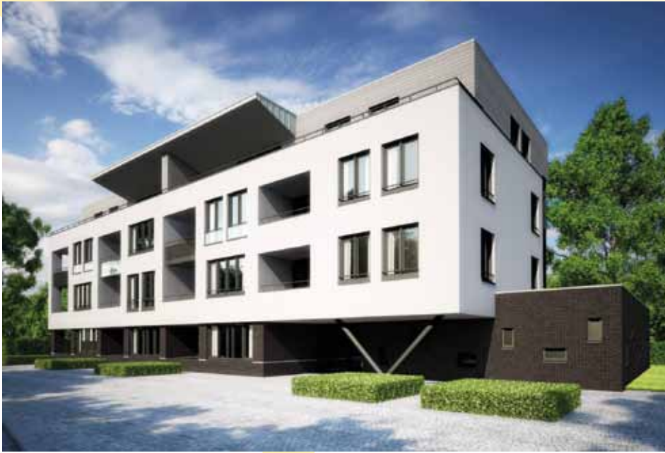
Bouwblok E, architect LancÈe
