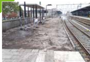
Asfaltverharding verwijderen
