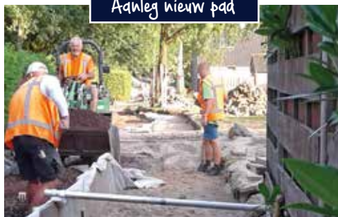
Aanleg nieuw pad
